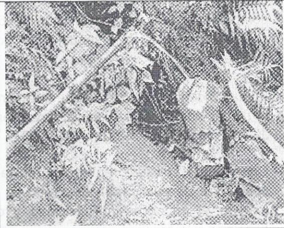
**Foto 2.** Llegada al balde (desarenado) en manguera de 2", y salida en manguera de ½". Captación quebrada el Tambo. Vereda Piñuelos. Jorge Vargas.
