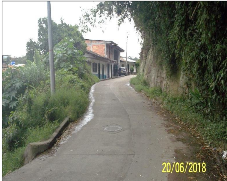
Ilustración 47. Coordenadas. Sector de la calle 3 con carrera 5, con susceptibilidad a caída de bloques. Fuente: Geocing SAS.
