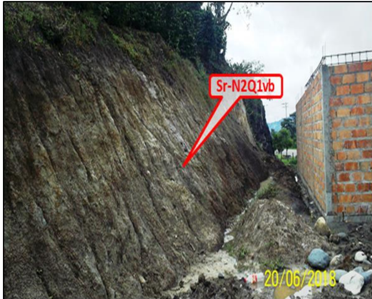
Ilustración 34. Coordenadas: E= 1090698, N= 699314, altura = 1656 m, orientación al oriente. Suelo residual en corte para vivienda Fuente: Geocing SAS
