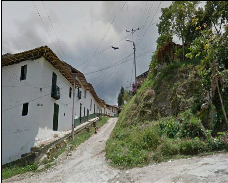
Ilustración 303 Vista de taludes expuestos inestables en el Barrio Los Olivos Fuente: Geocing SAS.
