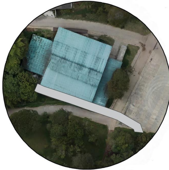
Ilustración 333. Localización Box Culvert– sector 6. Fuente: Geocing SAS.
