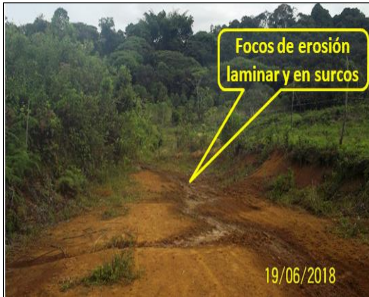
Ilustración 45 Sector con cortes para adecuación a futura zona urbanizable, donde priman procesos de erosión, en los sectores desprovistos de capa vegetal protectora.
