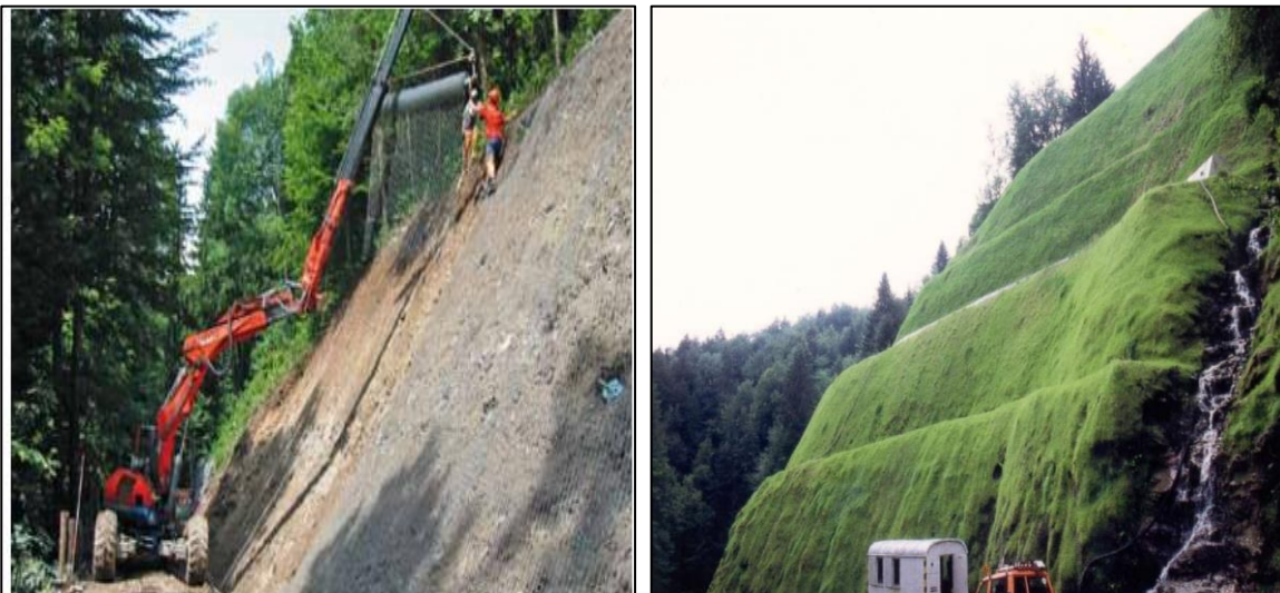
Ilustración 315 Vista implantación de la malla para estabilización y malla control de erosión. Fuente: Geocing SAS.
