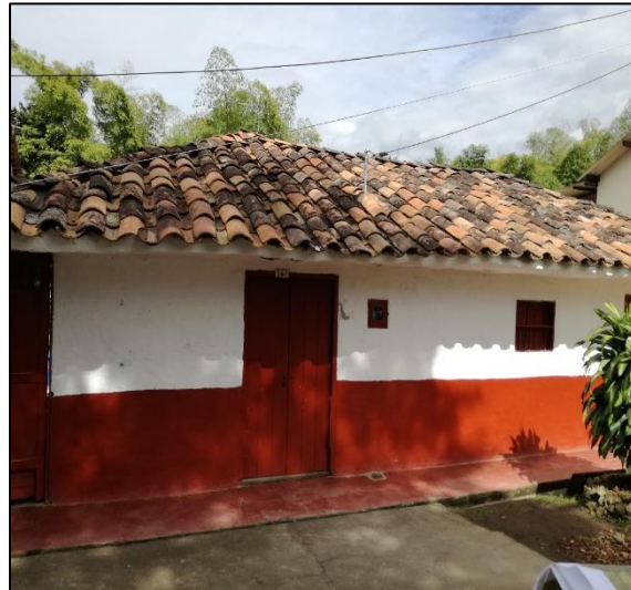
Ilustración 207. Vivienda Tipología B2 (Vivienda en mampostería sin estructura). Fuente: Geocing SAS
