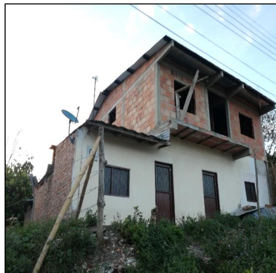
Ilustración 208. Vivienda Tipología B3 (Edificaciones hasta de dos (02) niveles de buena calidad de construcción (con estructura). Fuente: Geocing SAS
