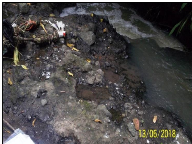
Ilustración 39. Coordenadas: E= 1089948, N= 699329, altura = 1590 m, orientación al noroccidente. Rocas de Lahar de Altamira, en cauce de quebrada. Fuente: Geocing SAS
