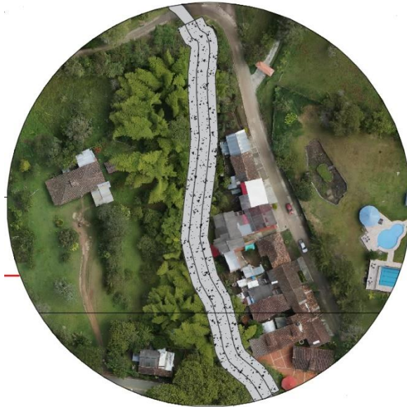
Ilustración 326. Quebrada Las Moyas ubicación de canal abierto sector 2. Fuente: Geocing SAS.
