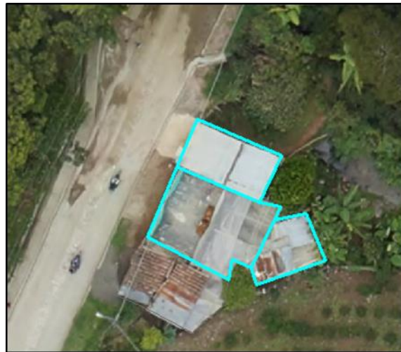
Ilustración 336. Zona Crítica– sector 8. Fuente: Geocing SAS
