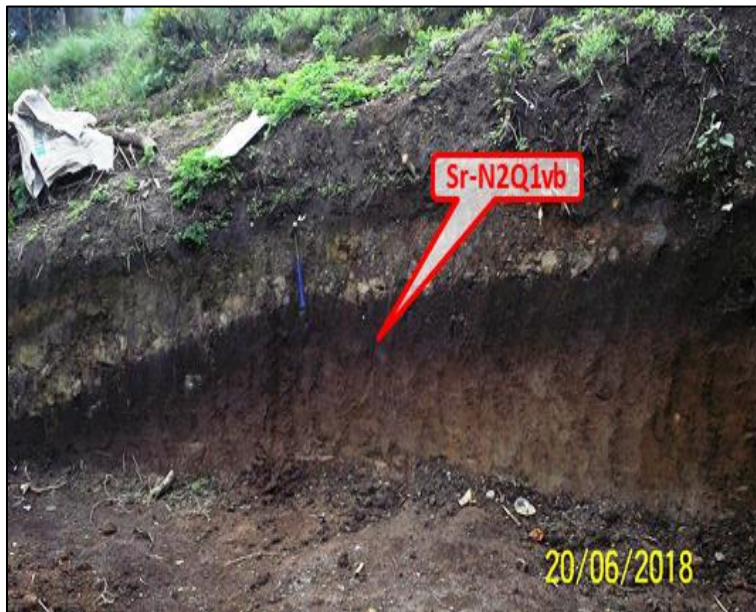
Ilustración 33. Coordenadas: E= 1090532, N= 699665, altura = 1680 m, orientación al norte. Suelo residual en corte para vivienda. Fuente: Geocing SAS.
