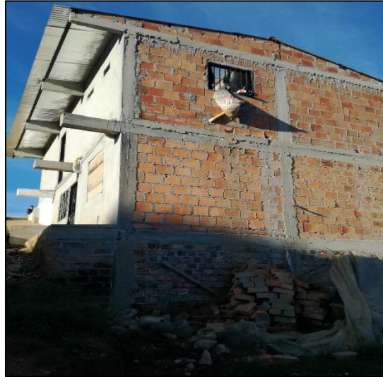
Ilustración 209. Vivienda Tipología B4 (Edificaciones de más de dos (02) niveles de buena calidad de construcción (con estructura). Fuente: Geocing SAS
