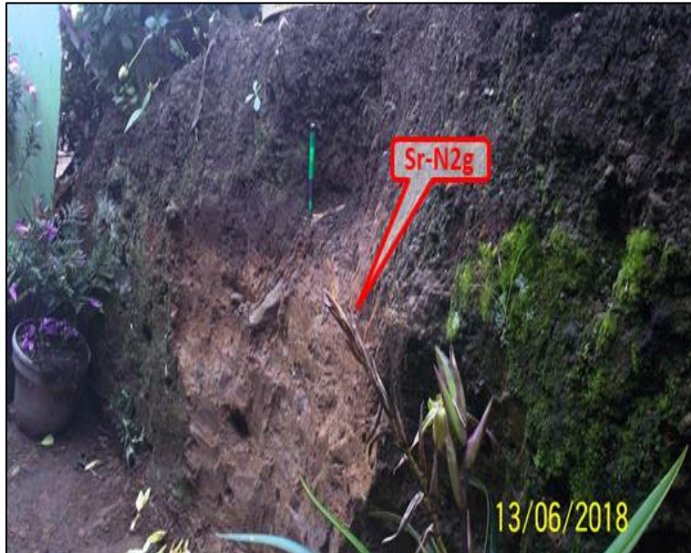
Ilustración 35 Coordenadas: E= 1090051, N= 699344, altura = 1613 m, orientación al oriente. Suelo residual en corte para vivienda. Fuente: Geocing SAS.
