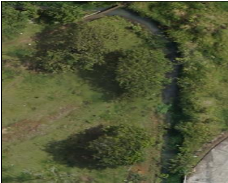
Ilustración 92. Canales del municipio de San Agustín. Fuente: Geocing SAS.
