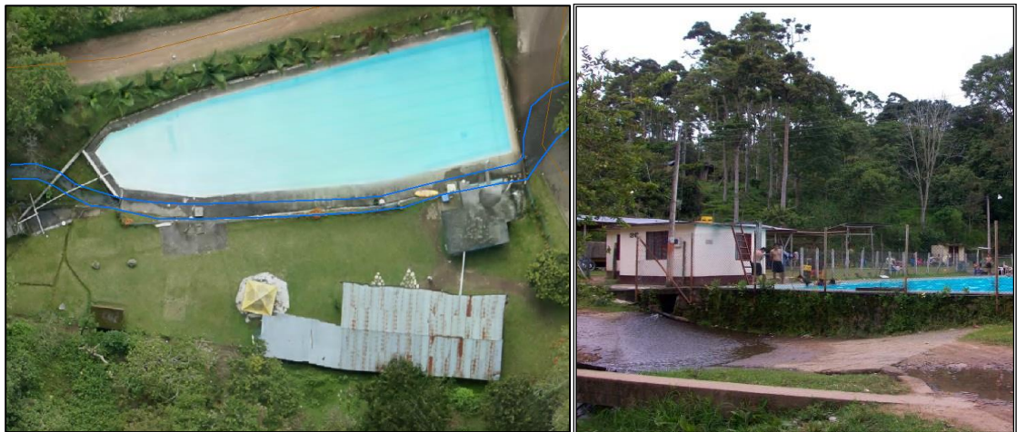
Ilustración 323. Quebrada Las Moyas ubicación de piscina sector 1.
