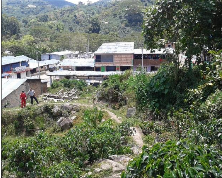
Ilustración 10 Viviendas ubicadas en la zona de amenaza alta por flujos torrenciales de la Quebrada Las Minas. Centro Poblado Los Cauchos. Fuente: (Municipio de San Agustín - Huila, 2012)
