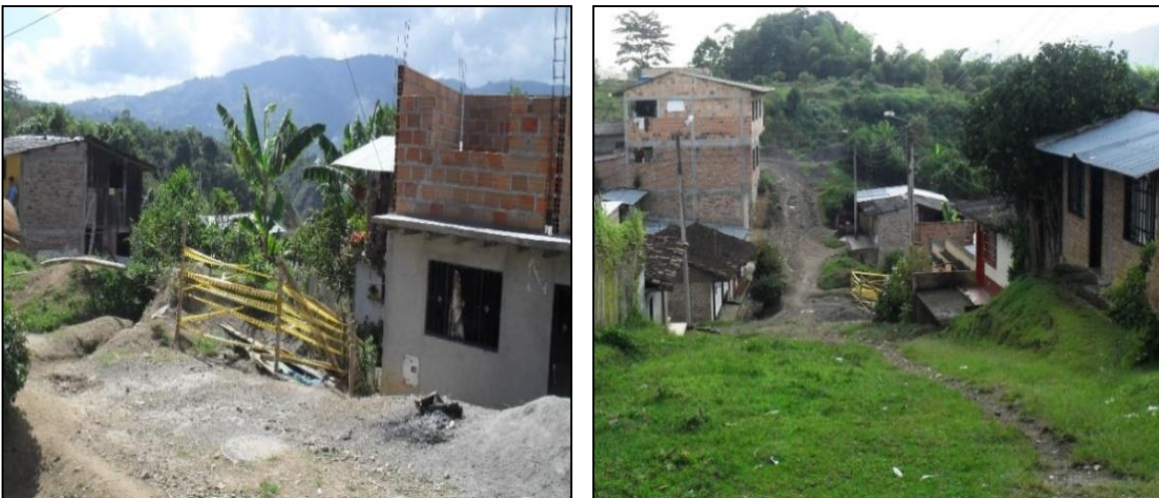
Ilustración 18. Barrió Nueva Alianza, sector de inundación por régimen alto de precipitaciones y escorrentía del agua. Fuente: (Municipio de San Agustín - Huila, 2012)
