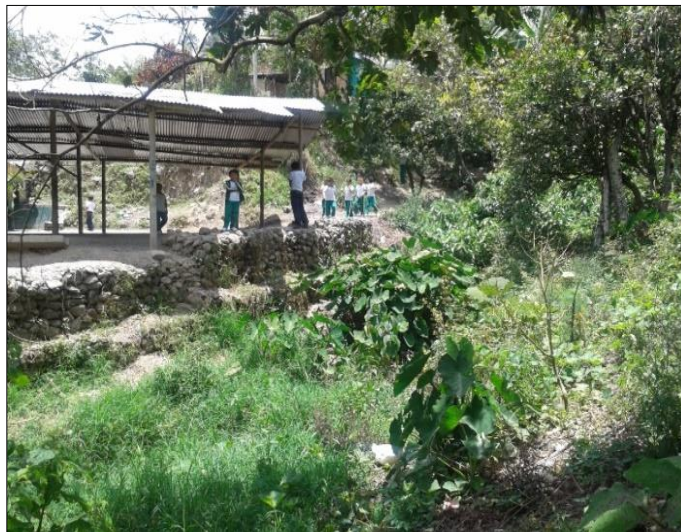
Ilustración 11 Escuela Los Cuchos ubicada en la zona de amenaza alta por flujos torrenciales de la Quebrada Aguas Claras. Fuente: (Municipio de San Agustín - Huila, 2012)
