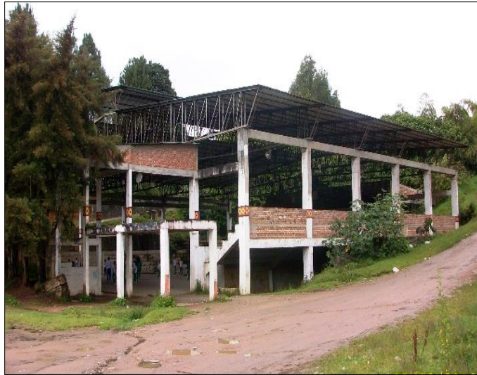
Ilustración 17 Sector Coliseo municipal. Canalización cerrada de la quebrada Las Moyas. Fuente: (Municipio de San Agustín - Huila, 2012).
