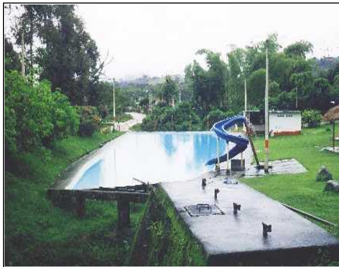
Ilustración 2. Sector de la piscina, que a causa de la canalización inunda el sector. Fuente: (CAM - Idea UN, 1999).
