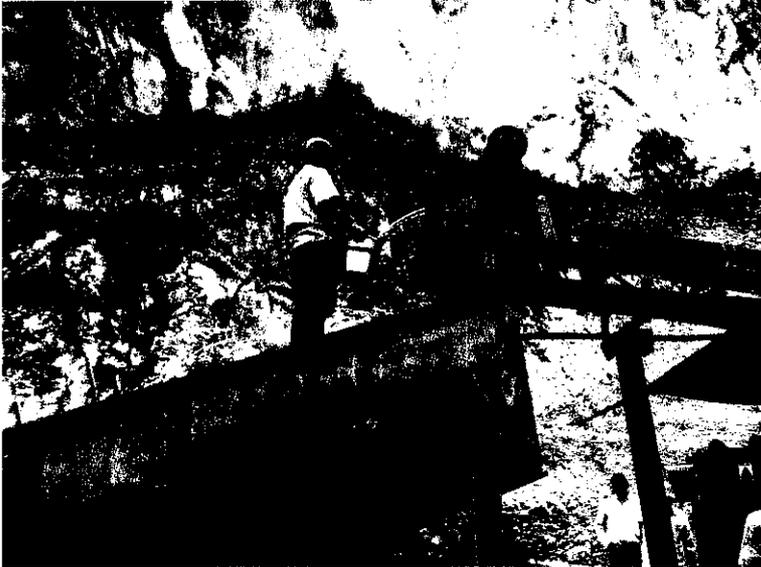
Fotografía No1. En el registro observamos la medición de caudal que se realiza por el método volumétrico en el punto al cual llega el agua la medición se realiza cinco veces y posteriormente se promedia obteniendo un caudal total de 5 lps.
