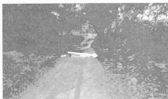
Foto 1. Sitio donde se construirá puente
