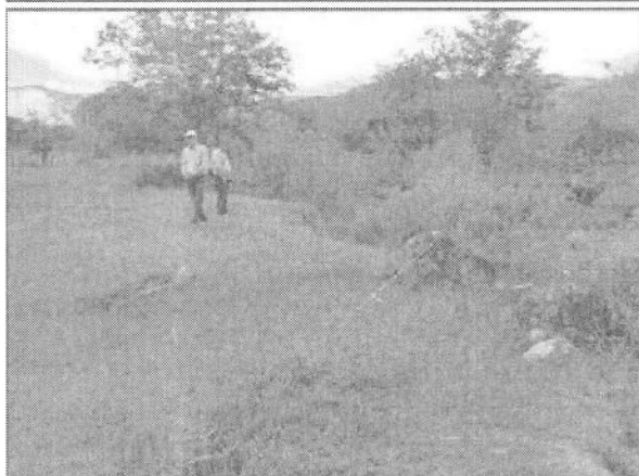
Fotos No.1 y 2. Vista general de la zona, aguas abajo la estructura existente.
