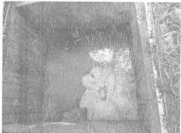
Foto N° 8 y 9. Trampa de grasas. Se observa material higiénico flotante.
