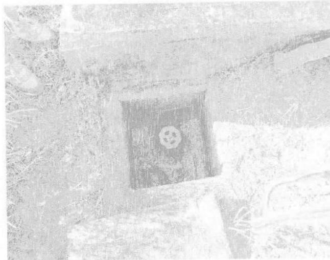
Foto N° 5 y 6. Válvula de bola, retiene el vertimiento resultante de la tanatopraxia, mientras se le aplica el hipoclorito de sodio.
