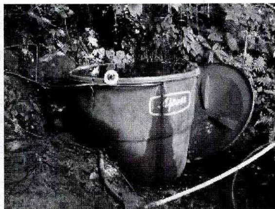
*Fotografía 4. Tanque de almacenamiento en la captación.*
