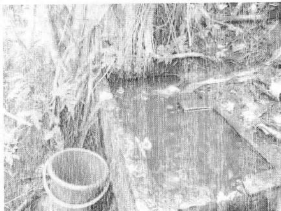
Fotografía 3. Captación mediante tanque en mampostería.
