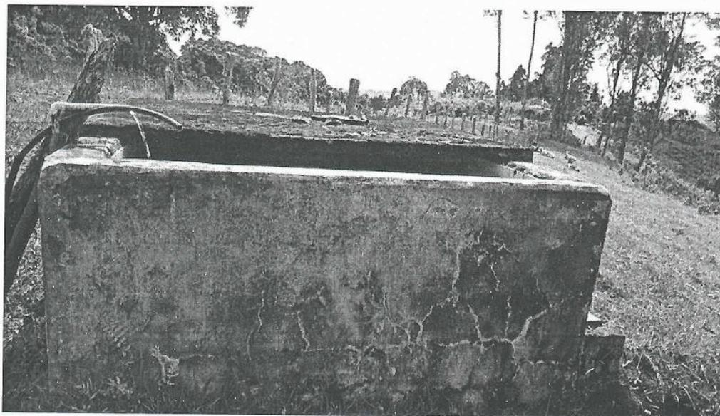
**Foto. N°. 4.** Tanque de almacenamiento de agua antes de distribución a usuarios
