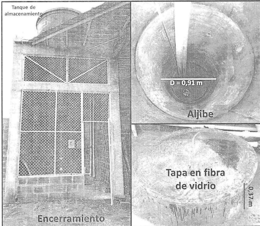
El sistema funciona automáticamente prendiendo o apagando la motobomba del aljibe con el empleo de flotadores automáticos, instalados al interior del tanque de almacenamiento de 1000 litros cada vez que distribuye o aumenta el nivel del agua dentro del mismo.
