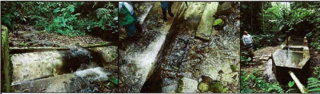
El sistema de captación está ubicado en las: coordenadas X: 0761500 Y: 0684052 a 1816 msnm, cuenta con desarenador, la captación es por rejilla y por gravedad se conduce al tanque de almacenamiento ubicado a 300 metros.
