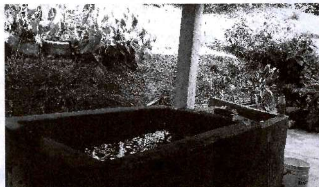
Fotografía 6. Tanques de almacenamiento de la vivienda.
