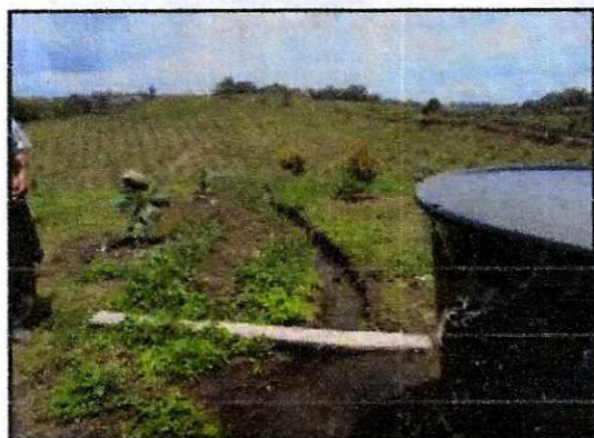
El sobrante generado en el tanque de almacenamiento discurre por zanja y se deposita en la quebrada La Chorrera en predios de la señora Sandra Córdoba,
