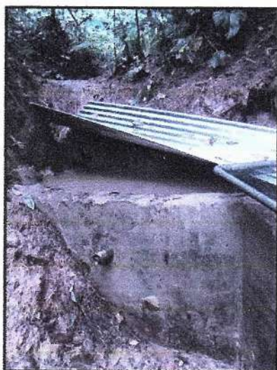
Bocatoma Coordenadas E772876-N679698 a 1807 msnm.
