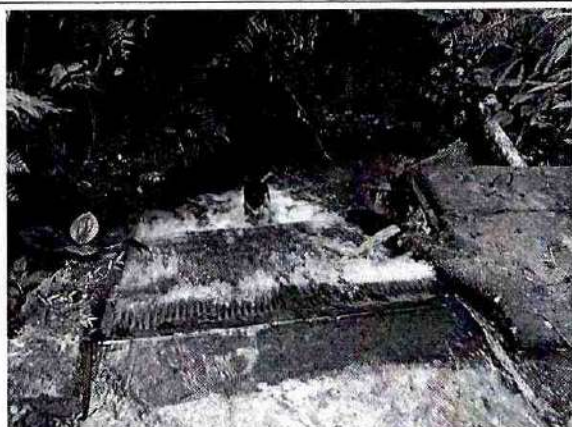
Fotografía 1. Estructura de toma de agua "bocatoma de fondo".
