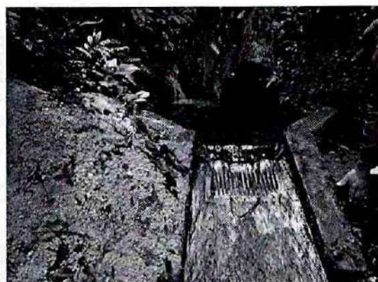
Fotografía 4. Estructura de toma de agua "bocatoma de fondo". N° 2.
