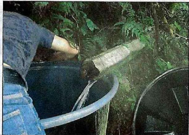
La captación se hace por gravedad con llegada a un tanque plástico que actúa como desarenado el cual está ubicado en la reserva Santa Teresa en las coordenadas **X: 0784444 Y: 0689226 a 1.901 m.s.n.m**,
