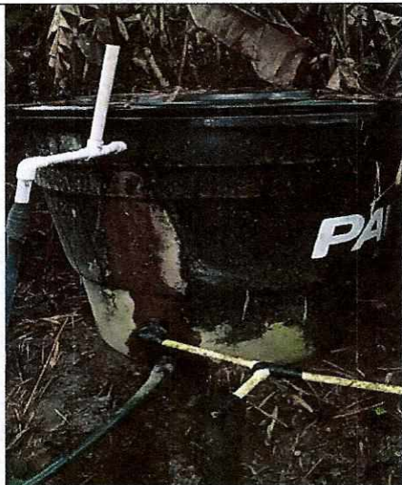
Fotografía 3 tanque de almacenamiento del recurso hídrico
