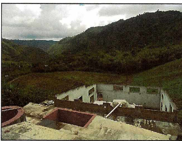
Está en construcción el sitio para beneficiar el café.
