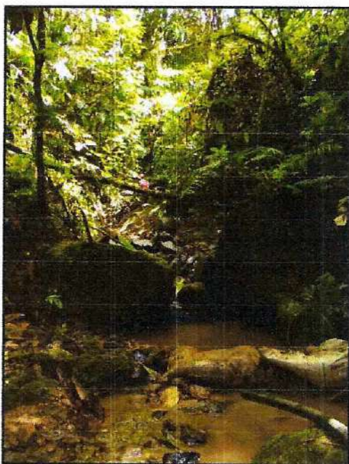
Captación Quebrada Los Negros
