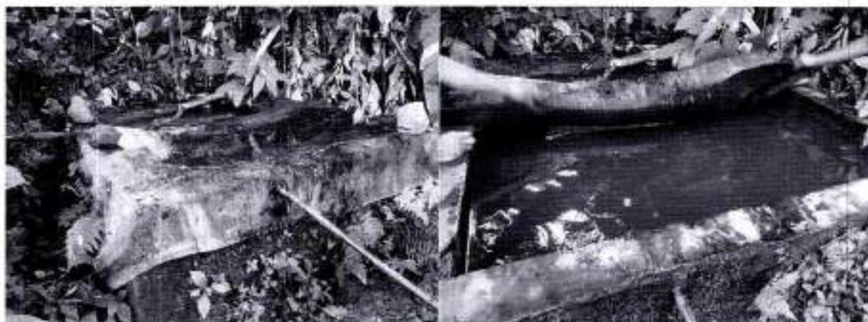
**Tanque de Almacenamiento:** El sistema cuenta con un tanque de almacenamiento en mampostería con revestimiento de concreto impermeabilizado, con un volumen total de 5400 litros. En la base del tanque se observan 7 salidas de las cuales 2 se encuentran suspendidas y 5 activas en diámetros de  $1\frac{1}{2}$ " (1) y  $\frac{3}{4}$ " (4).
