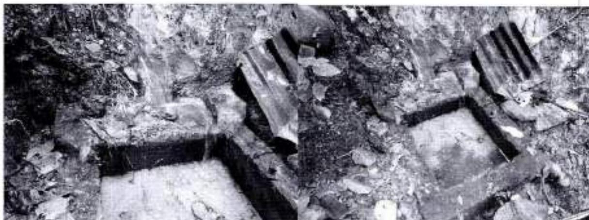
**Tanque desarenador:** Consiste en una estructura en mampostería revestida en concreto, prismática de base rectangular con dos compartimentos, de 1.54 metros de largo, 1.80 m de ancho y 0.76m de profundidad, con salida doble en manguera de polietileno de  $\frac{3}{4}$ ".
