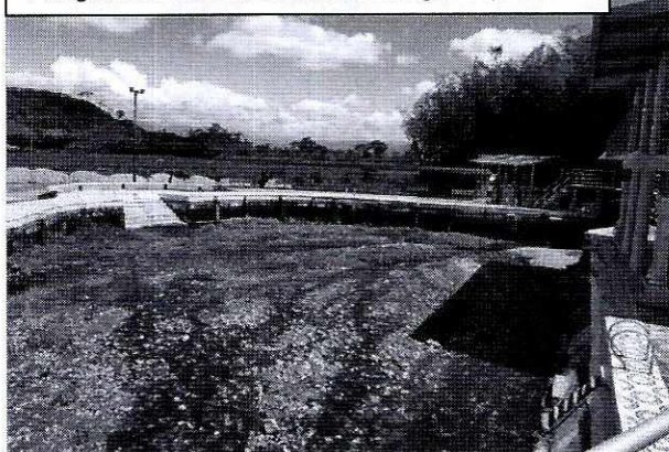
Fotografía 5. Muro de contención margen izquierda.
