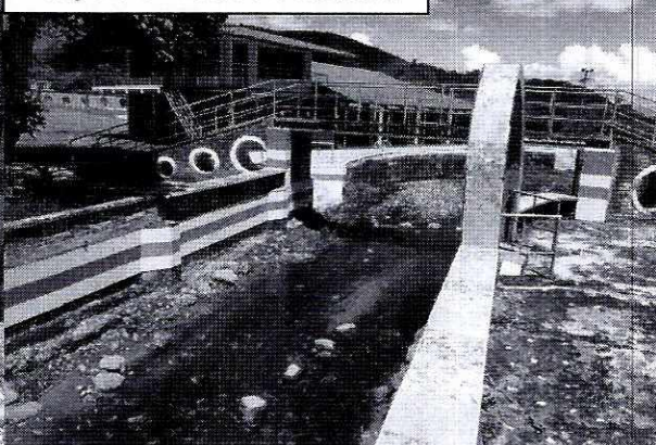
Fotografía 6. Entrada a la estructura
