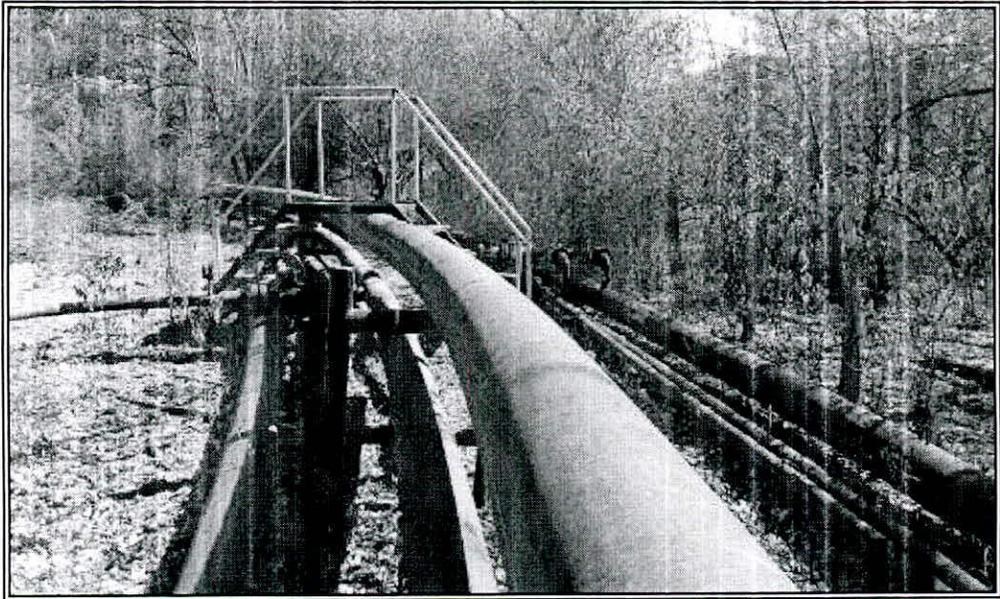
Fotografía 8: Red de tubería existente donde se construirá una nueva que se soportará sobre las H, para el transporte de gas.
