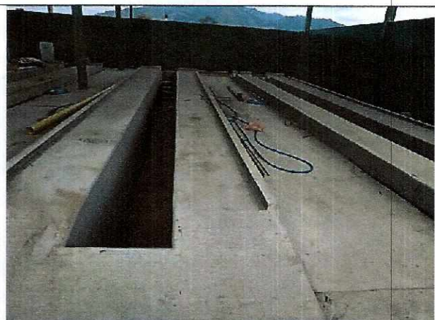
Fotografía 2. Cárcamos para lavado
