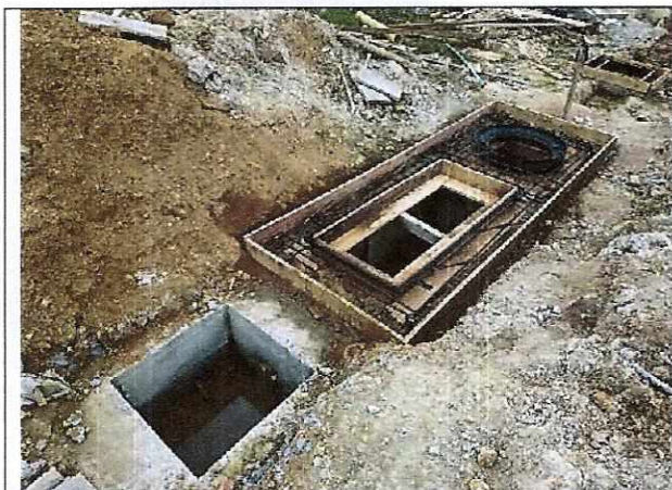
Fotografía 7. Trampa de grasas en construcción
