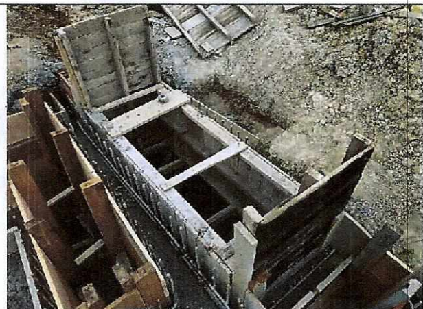
Fotografía 8. Sedimentador en construcción
