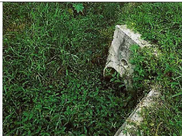
Fotografía 5. Punto de descarga del vertimiento a quebrada Agua Dulce
