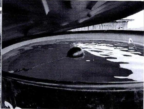
Fotografía 10. Válvula de flotador
