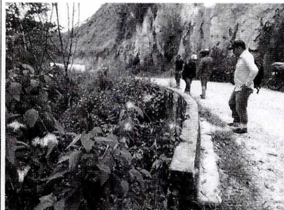
Fotografía 2. Zona en donde se construirá el muro en PR 7+470 vereda Arrayanes.
