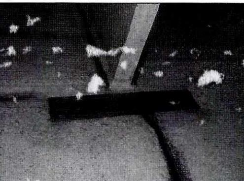
Rejillas localizadas en las diferentes áreas de la planta de beneficio, las cuales retienen solidos disminuyendo la carga sobre el sistema de tratamiento de agua residual.
