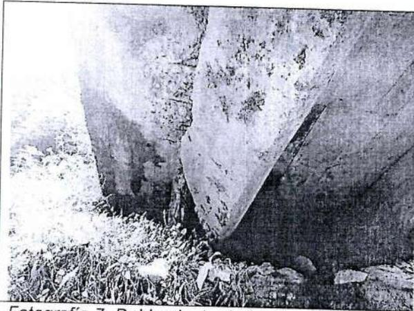
Fotografía 7. Doblamiento de la vía hacia el centro del puente
