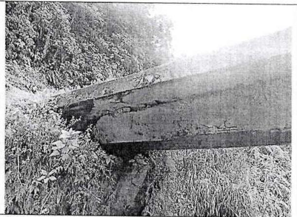
Fotografía 6. Fractura de la viga
