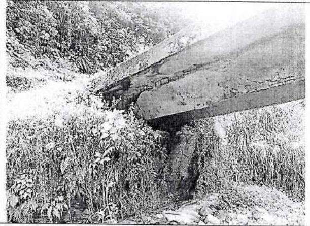
Fotografía 4. Inclinación del estribo izquierdo del puente
