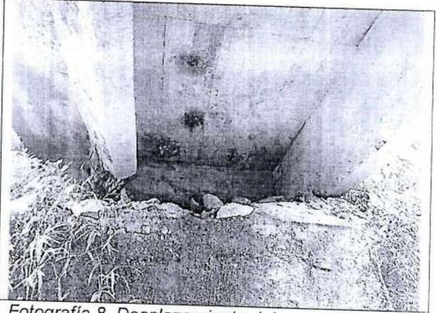
Fotografía 8. Desplazamiento del apoyo.
