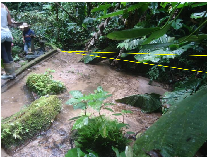
Bocatoma de Fondo
