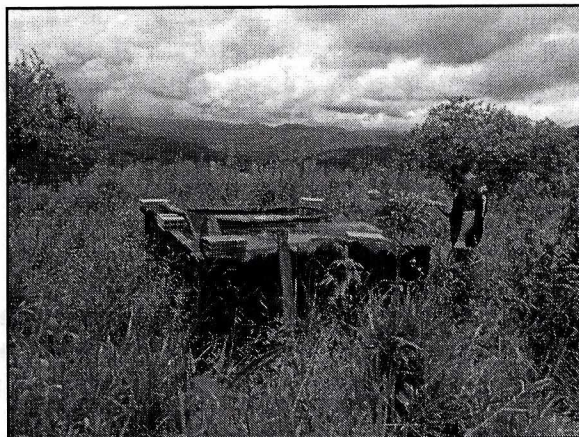
Tanque de almacenamiento vivienda predio El Paraíso
