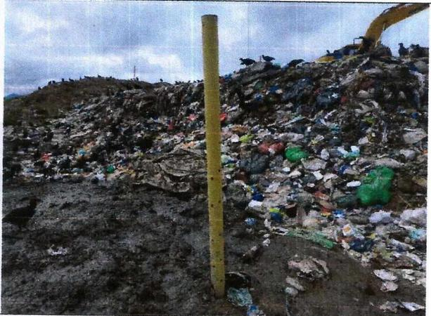
*Fotografía 8. Chimenea de evacuación de gases*
