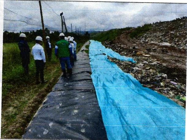
*Fotografía 4. Geomembrana de impermeabilización y geotextil de cobertura diaria*
