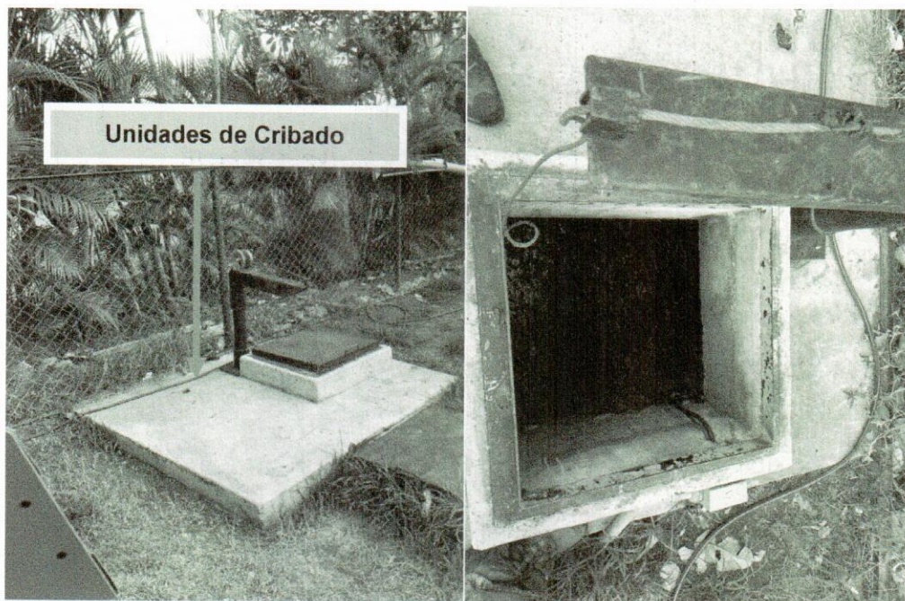
Fotos 2 y 3. Tanque de Almacenamiento Inicial
