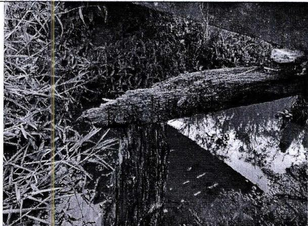
*Fotografía 3. Estado de los apoyos del puente existente*
