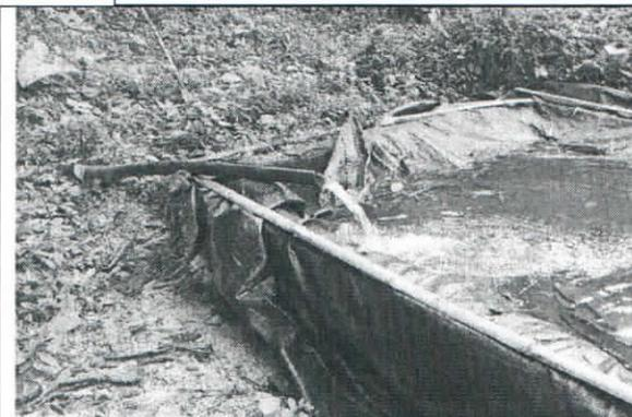
**Fotografía 12.** Flujo hídrico que llega al tanque de almacenamiento
