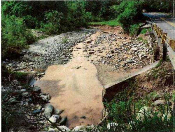
**Fotografía 1.** Aguas arriba quebrada La Turbia. Se observa aleta de contención Norte averiada.
