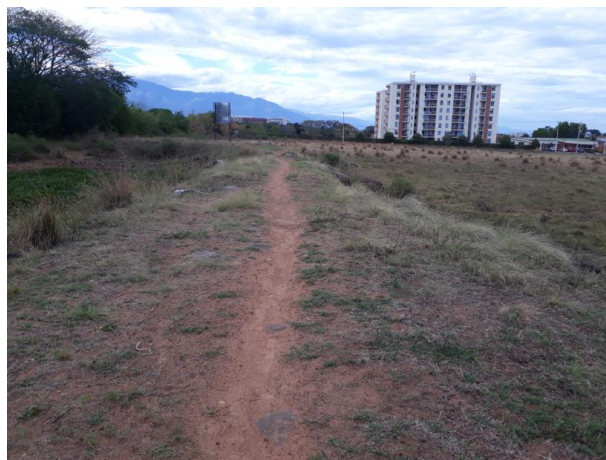
Figura 30. Dique construido con estériles de construcción en el costado occidental del humedal
