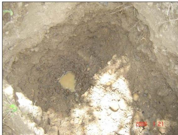
**Foto 22 - 3: Fondo de la excavación. Presencia del nivel freático. Profundidad aproximada 1,30 m.**
