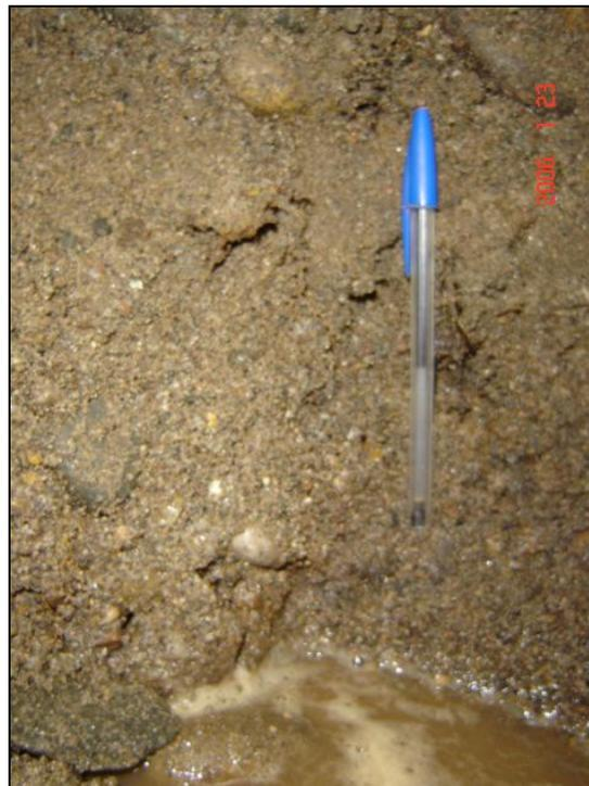
**Foto 33 - 3: Fondo de la excavación. Presencia del nivel freático. Matriz de arena con gujarros. Profundidad aproximada 1,00 m.**
