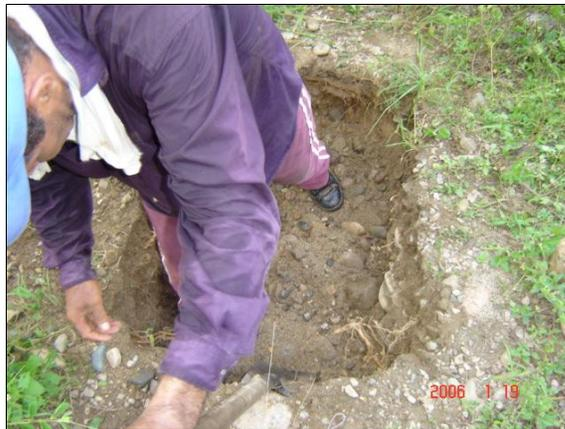
**Foto 3 - 2: Se aprecia el fondo de la excavación consistente en matriz arenosa con guijarros de gran tamaño que dificultaron las perforaciones y obligaron a la ejecución de apiques.**
