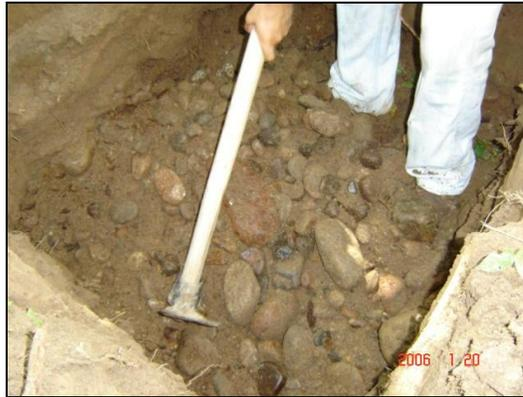
**Foto 7 - 3: Fondo de la excavación. Observar el tamaño y la gran cantidad de guijarros encontrados. Profundidad aproximada 0,80**
