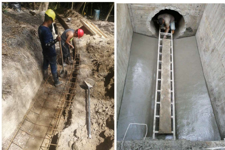
Obras del plan maestro de alcantarillado, Pitalito
