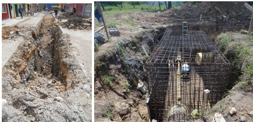
Obras del plan maestro de alcantarillado, Acevedo
