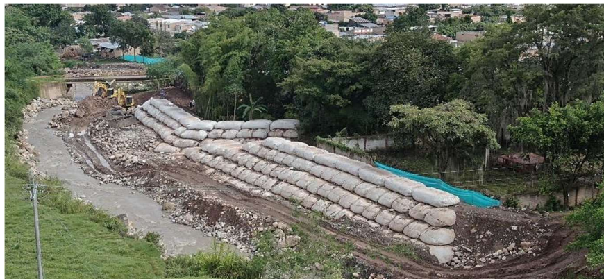
Obra de canalización del río Timaná. Construcción de dique o muro de protección
