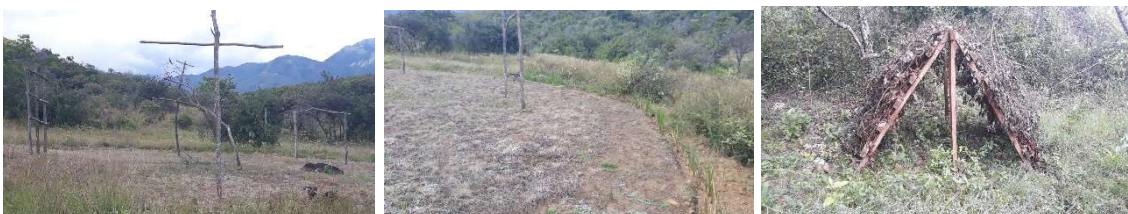
Construcción de refugios de fauna y perchas
