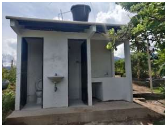
Batería Sanitaria vereda Santa Lucía
