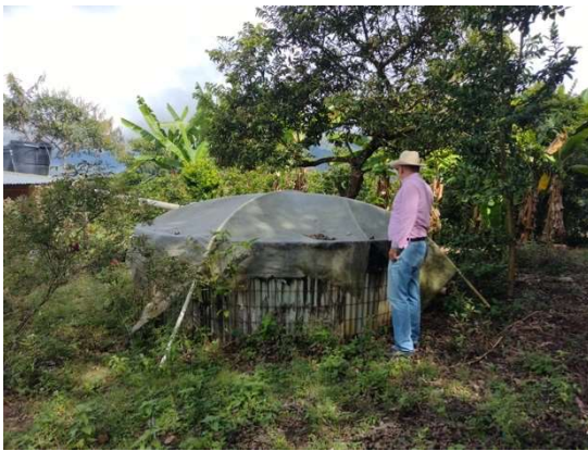
Tanque australiano usado como almacenamiento de aguas lluvias- Luis Murcia vereda Chapuro
