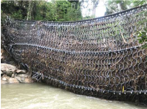
Barrera dinámica con acumulación de detritos y material vegetal proveniente de creciente del río Las Ceibas
