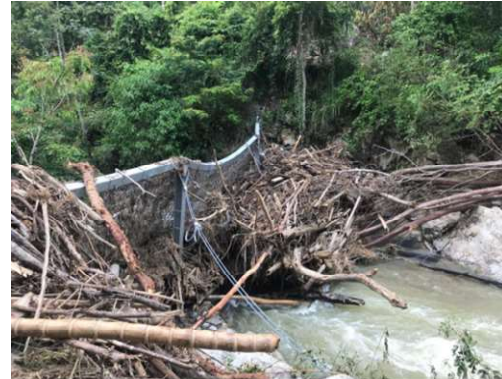
Barrera dinámica con acumulación de detritos y material vegetal proveniente de creciente del río Las Ceibas
