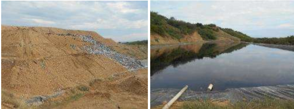
Celda de disposición final y piscina de lixiviados
