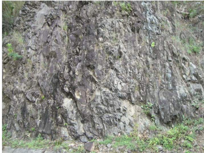
Foto 2.3 Ubicación del portal de entrada al túnel de conducción Santa María (Cerro de la Cruz)
