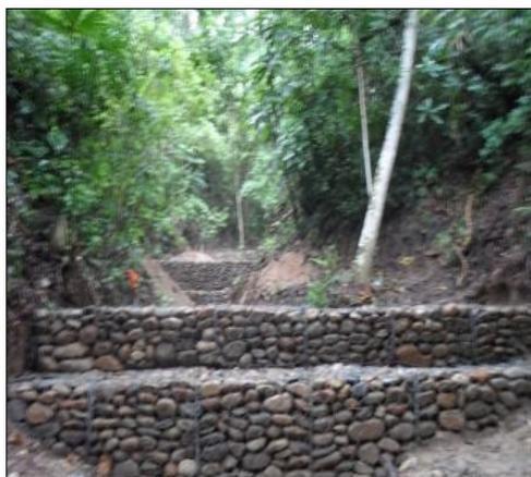
Obra de Control Hidráulico – reducción del riesgo Quebrada El Salado Rivera
