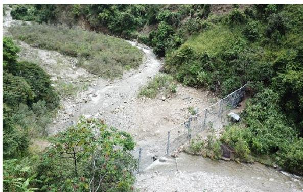
Barrera dinámica contra flujo de detritos de tipo UX Geobrug.
