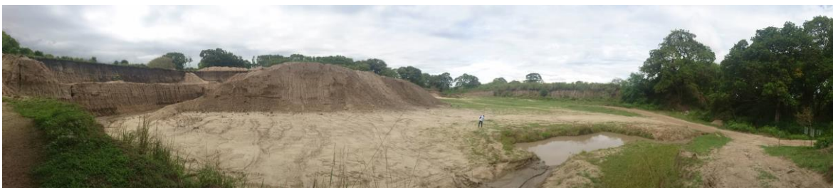
Seguimiento a UPM Material de arcilla jurisdicción del municipio de Campoalegre. (Título minero 13448).
