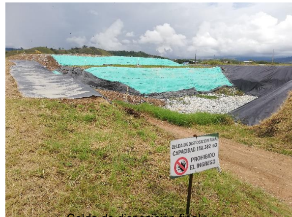
Celda de disposición final
