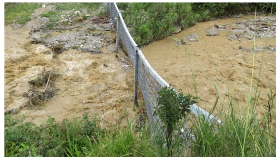
Barrera dinámica con acumulación de detritos y material vegetal proveniente de creciente del río Las ceibas en la parte alta. Ubicada en la vereda Motilón, paralelo al Km 38 de la vía Neiva – Balsillas.
