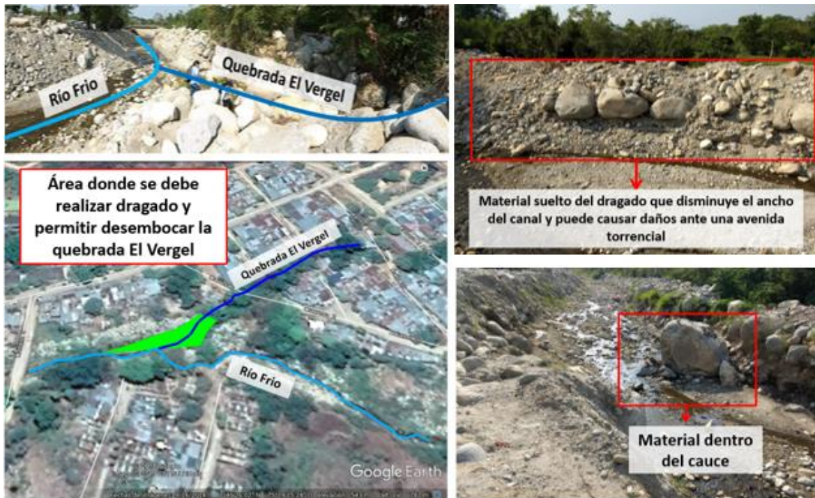
Registro Fotográfico. Seguimiento a obras en el Río Frío municipio de Campoalegre Huila.
