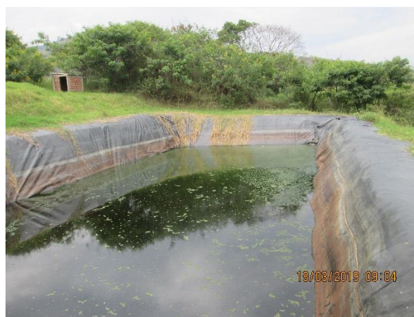
Piscina de Lixiviados
