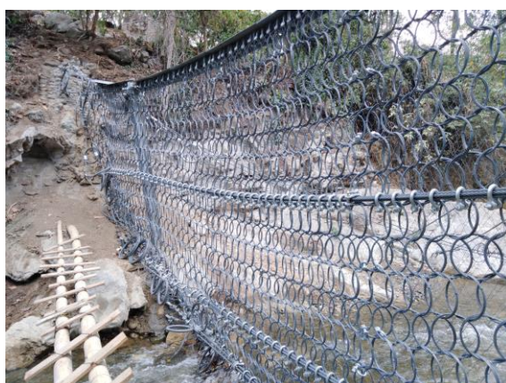
Construcción de la barrera dinámica UX180-H6-Espec, que se ubica sobre el río Las Ceibas, paralelo al Km 18 de la vía Neiva – Balsillas.
