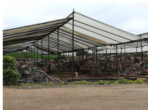
Zona de compostaje
