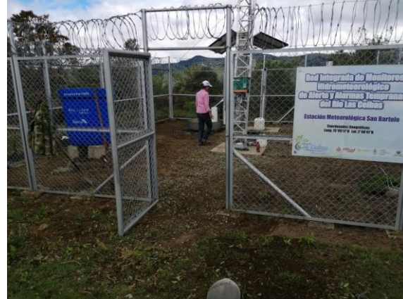
Mantenimiento preventivo estación meteorológica San Bartolo. Junio 2019.
