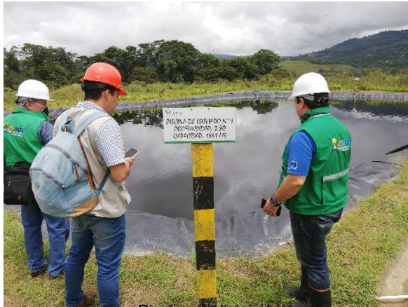
Piscina de lixiviados
