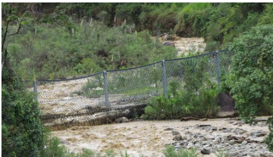
Barrera dinámica con acumulación de detritos y material vegetal proveniente de creciente del río Las ceibas en la parte alta. Ubicada en la vereda Motilón, paralelo al Km 38 de la vía Neiva – Balsillas.
