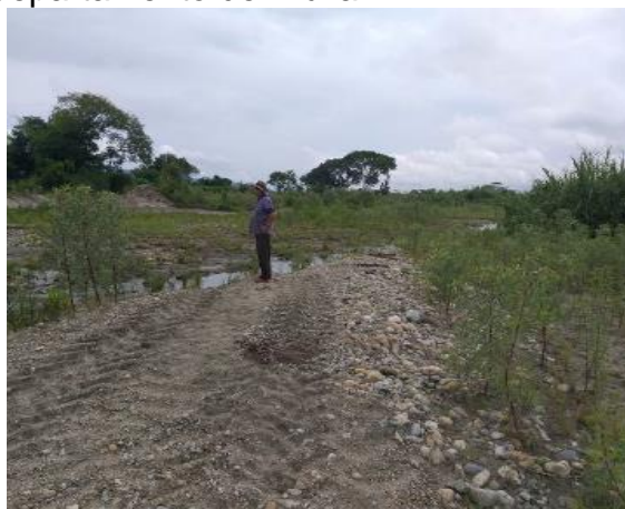
Daños en los Canales o Acequias de captación del recurso del Rio Ceibas - Neiva
