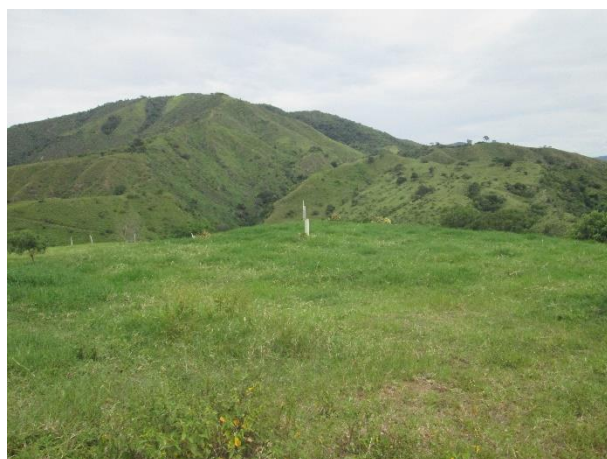
Celda de disposición final
