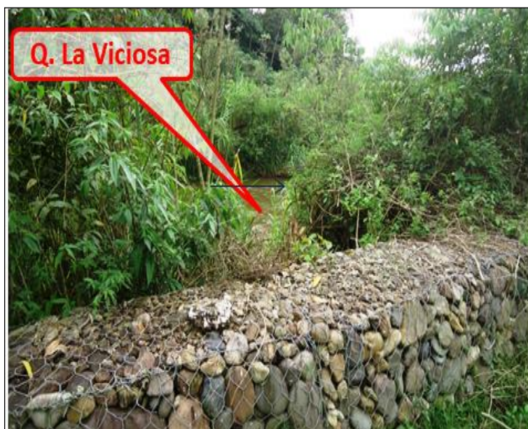
Ilustración 35. Coordenadas: E= 1147848, N= 716106. Muro en gaviones sobre la margen derecha de la quebrada la Viciosa, implantados al parecer para minimizar efectos de socavación lateral y de inundaciones.
