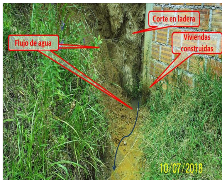
Ilustración 36. Coordenadas: E= 1146846, N= 715133. Brote de agua en corte realizado para construcción de viviendas. Fuente: Geocing S.A.S.
