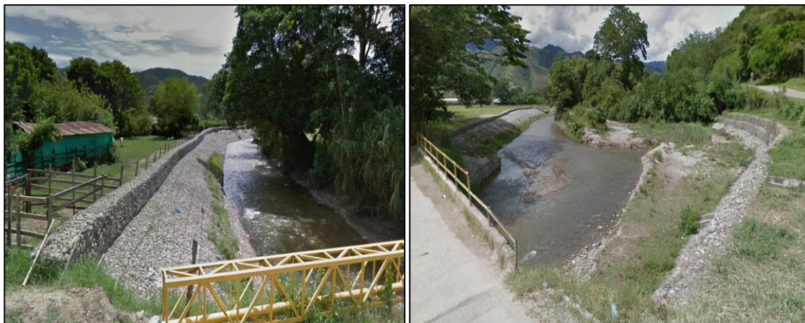
Ilustración 258. Muro en gaviones sobre la margen derecha de la quebrada la Viciosa. Fuente: Geocing S.A.S.
