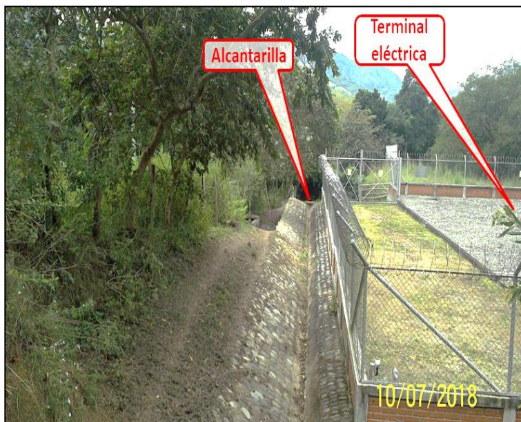
Ilustración 28. Coordenadas: E= 1146401, N= 715332. Se observa entubado de escorrentía del costado occidental de la terminal eléctrica. Fuente: Geocing S.A.S.
