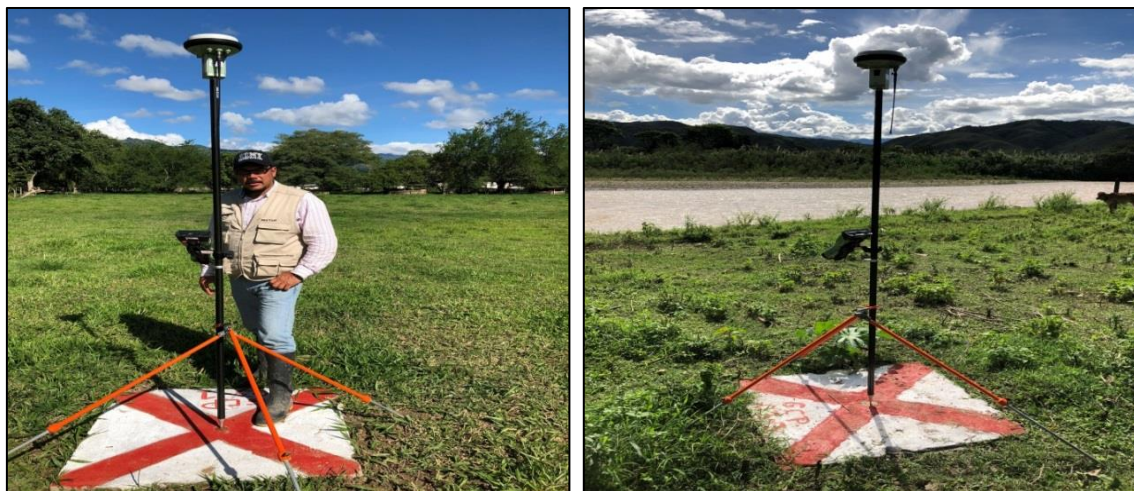
Ilustración 4. Procedimiento en campo toma de GCP. Fuente: Geocing S.A.S.
