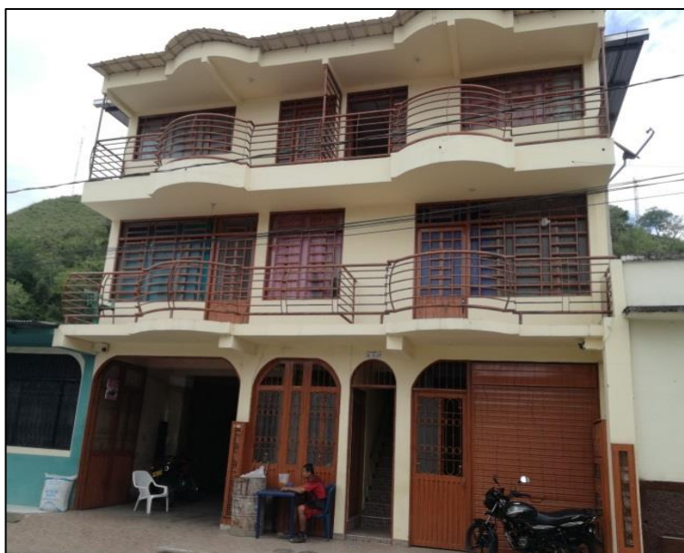
Ilustración 201. Vivienda Tipología B4 (Edificaciones de más dos (02) niveles de buena calidad de construcción (con estructura). Fuente: Geocing S.A.S.
