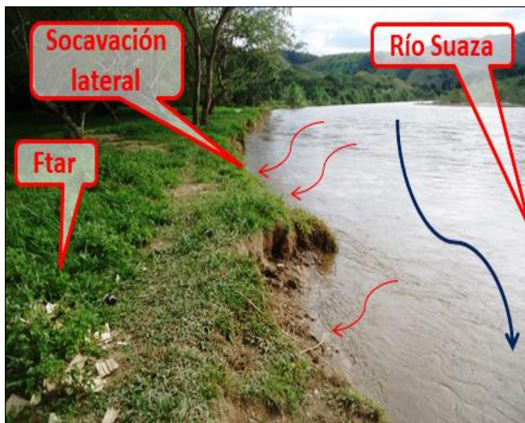
Ilustración 29. Coordenadas: E= 1146667, N= 715960. Socavación lateral sobre la unidad de Ftar. Fuente: Geocing S.A.S.
